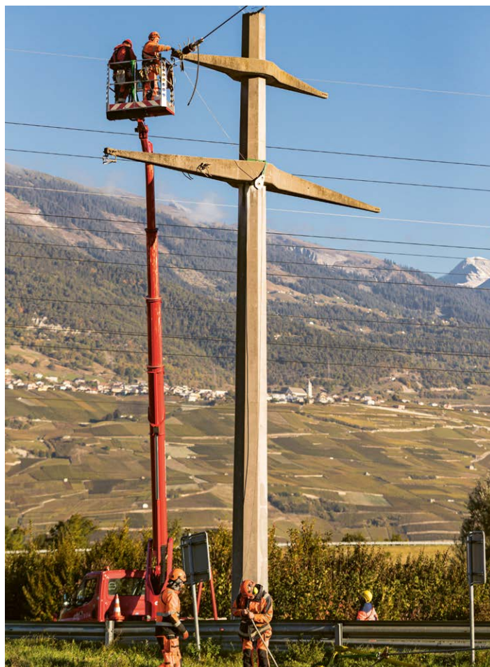
Le démontage de la ligne de 65 kV Riddes – Vétroz en automne 2021
